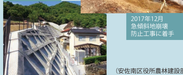
2018年10月 急傾斜地崩壊防止工事が完成
