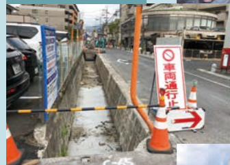
2018年4月 岩谷川の暗渠化工事
