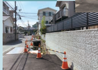
2019年2月 全体の工事は来年2月に完成予定
