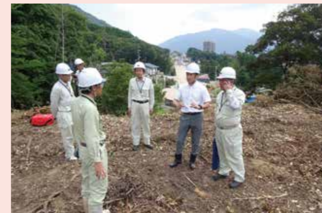
長束八木線建設現場
